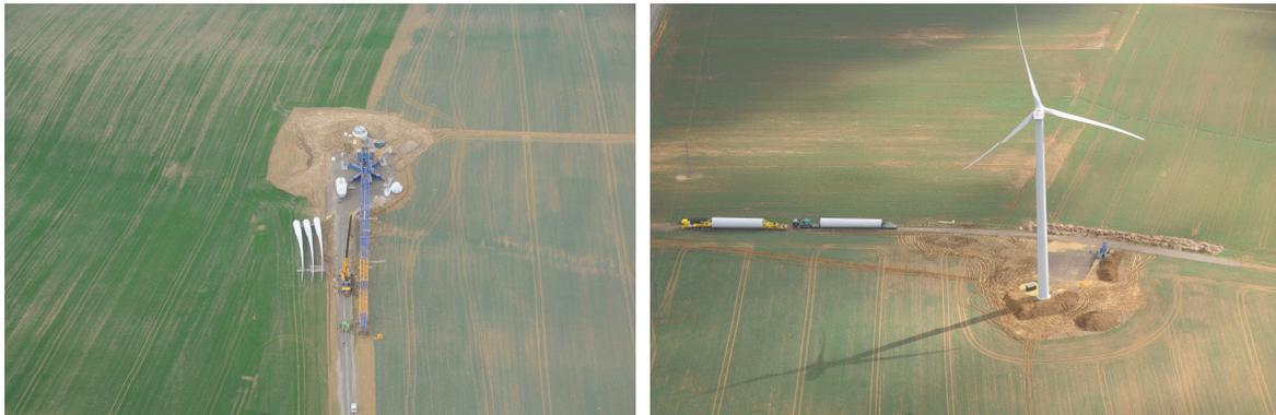
Figure 10 : Photos des emprises vis-à-vis des zones cultivées pendant et après les travaux
