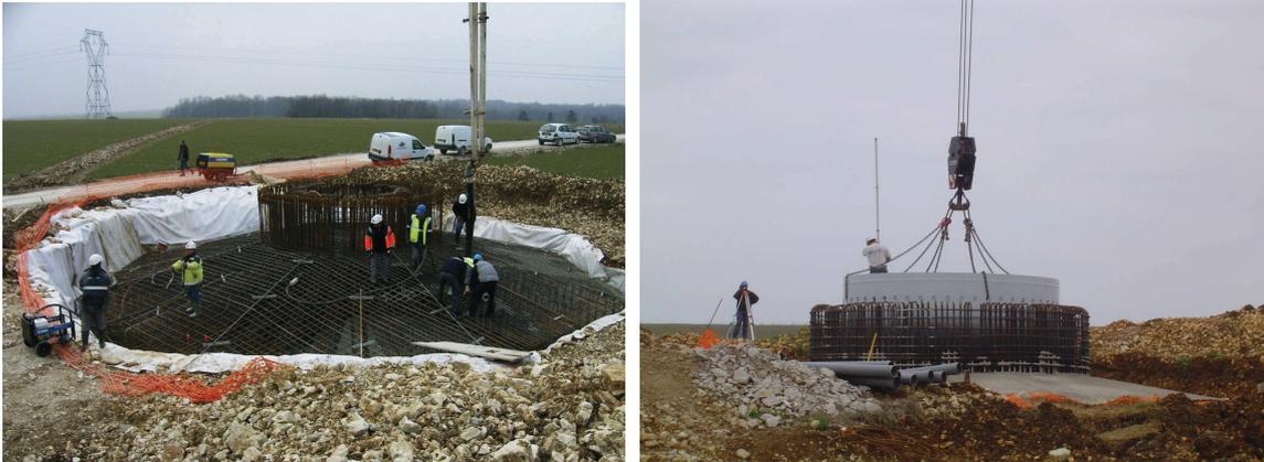
Figure 9 : Photos d'une fondation type avec le système de fixation du mât
